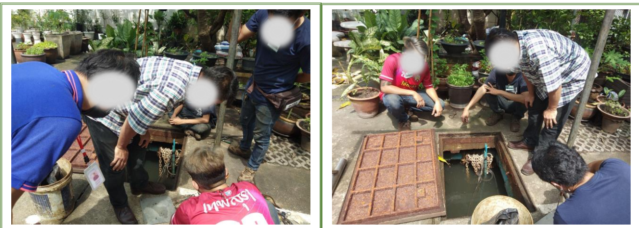
รูปภาพที่ 1.17 – การดูแลรักษาระบบบำบัดน้ำเสียซ่อมบ่อบำบัดน้ำเสีย โดยการซ่อมแซมบ่อบี้นที่ชำรุด
