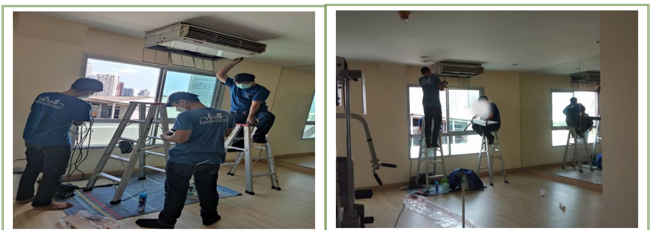
รูปภาพที่ 1.42- โครงการดำเนินการล้างทำความสะอาดเครื่องปรับอากาศตามรอบการบำรุงรักษา
