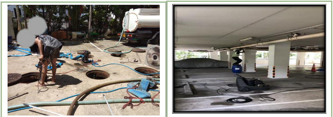
รูปภาพที่ 1.14 – การทำความสะอาดท่อตกไขมันส่วนกลาง ท่อระบายน้ำทิ้ง ป่อเกรอะ บ่อดักไขมัน ประจำปี
