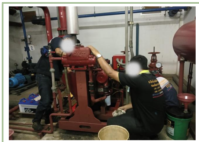
รูปภาพที่ 1.27 – เครื่องสูบน้ำดับเพลิง
