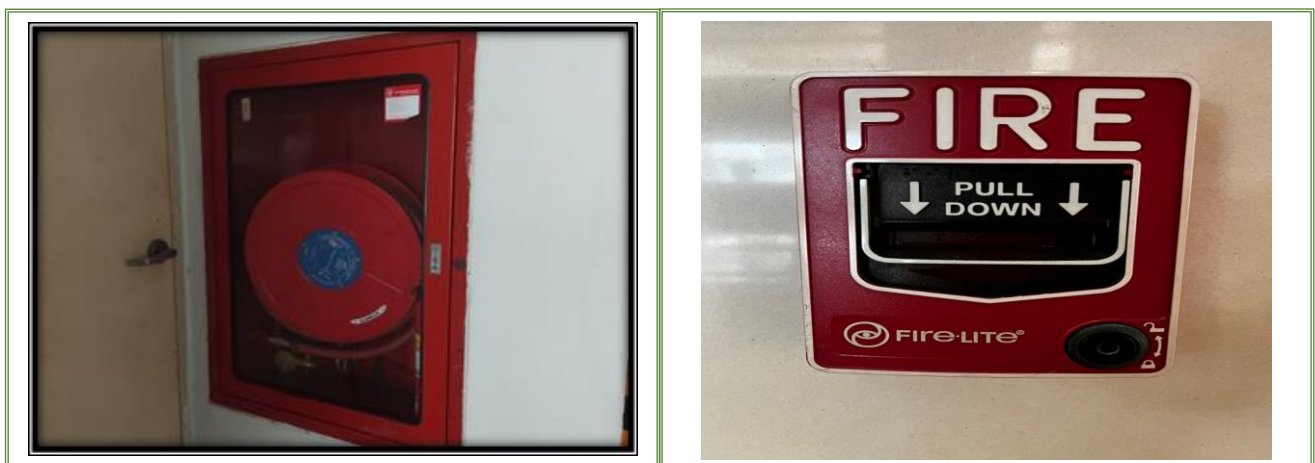
รูปภาพที่ 1.29 – ระบบท่อเย็น ระบบดับเพลิงและคำแนะนำในการใช้อุปกรณ์แต่ละตัว
